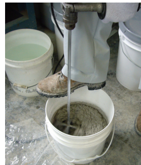
電動ドリルでの練混ぜ
