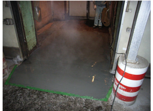
冷凍倉庫出入口の床面補修
