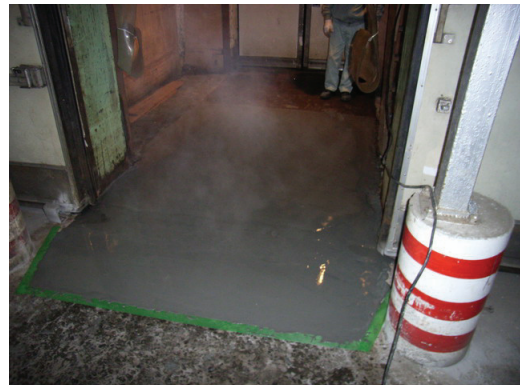
冷凍倉庫出入口の床面補修
