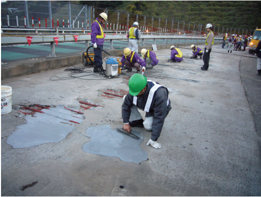
ジョイント後打ち部の緊急補修
