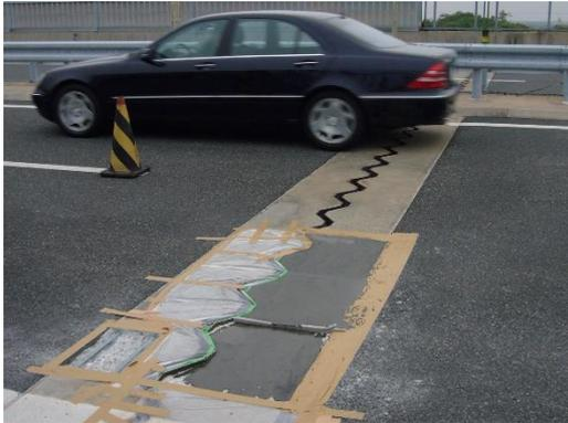
E T Cレーン段差解消補修
