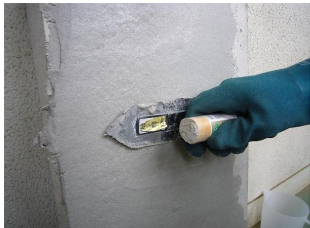
壁面の薄塗り補修
