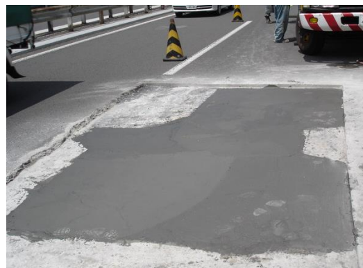
E T Cレーン段差解消補修
