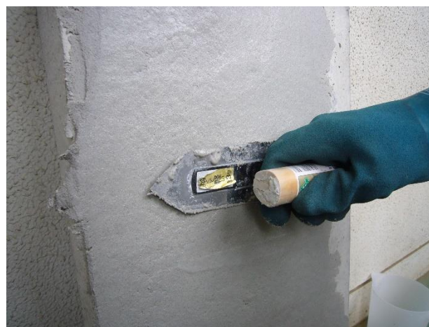
壁面の薄塗り補修
