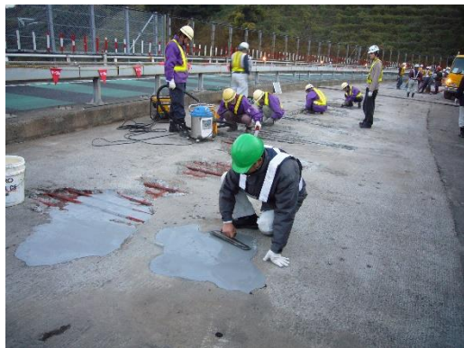
ジョイント後打ち部の緊急補修
