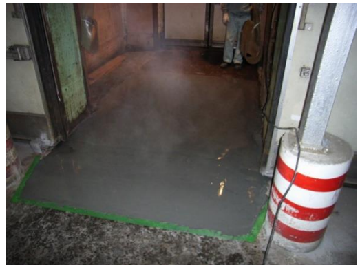
冷凍倉庫出入口の床面補修
